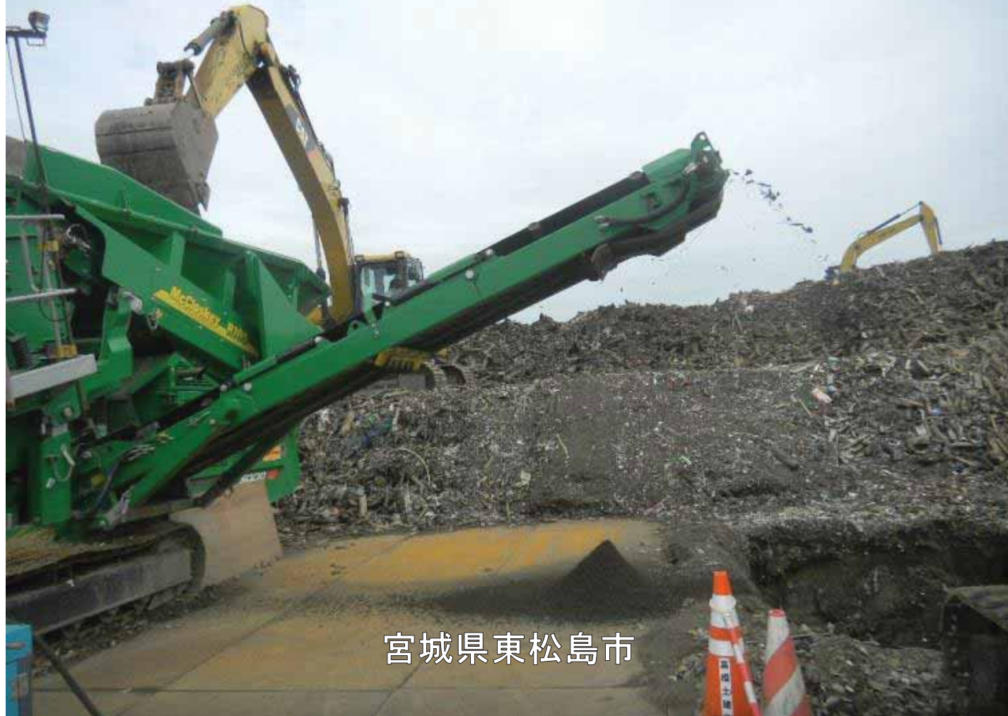
2607_5_018_044811_東松島市_2012.8.2_大曲浜災害廃棄物仮置場
