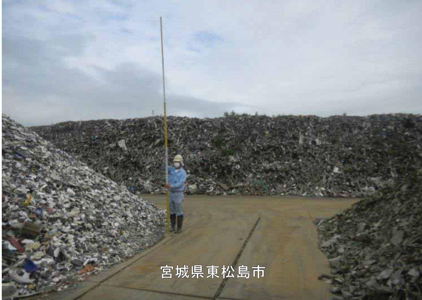
2607_5_018_044786_東松島市_2012.8.2_大曲浜災害廃棄物仮置場
