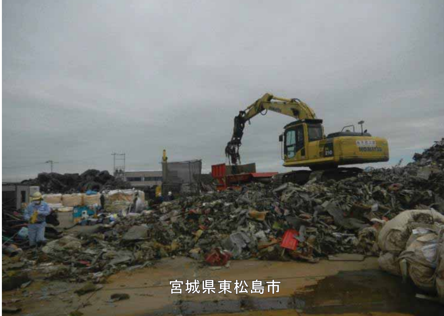
2607_5_018_044814_東松島市_2012.8.2_大曲浜災害廃棄物仮置場
